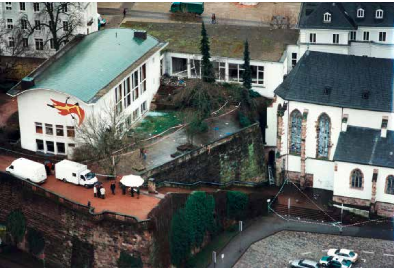
Am Tatort – Polizeibeamte untersuchen das beschädigte VHS-Gebäude und die Saarbrücker Schlosskirche (© Roman Schmidt).
